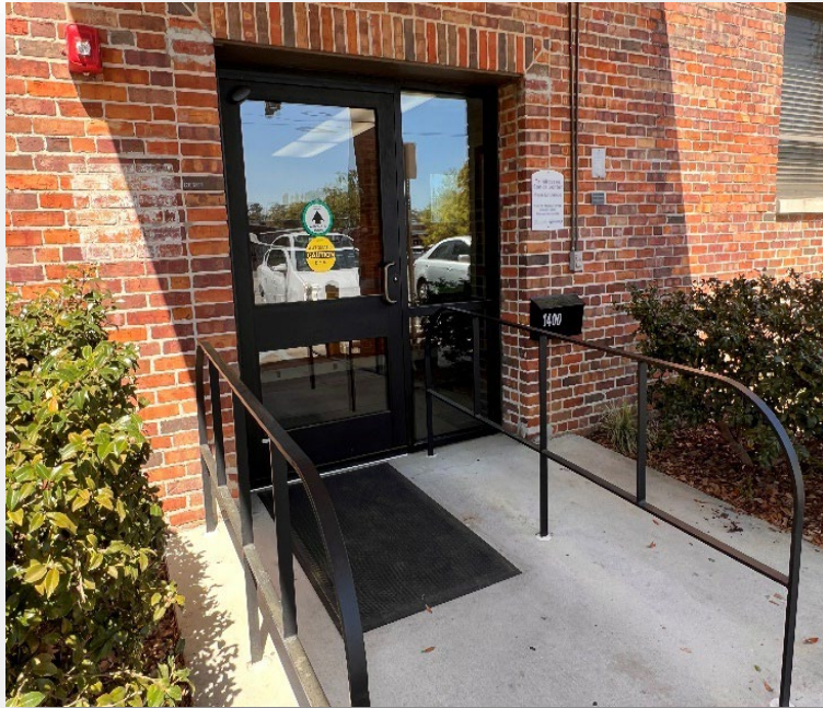
New ADA Main Entrance Door
